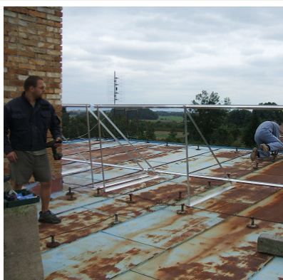
Sestavit rámy k upevnění solárních panelů bylo ze začátku oříškem
