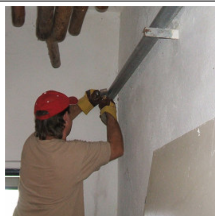
Zde bude další průchod pro centrální rozvod vody, doufejme, že nám nevypadne půlka zdi
