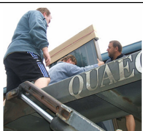
Dostat solární panely na střechu pomohla technika
