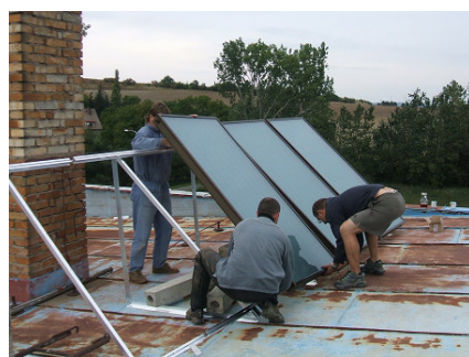
Sestavit rámy k upevnění solárních panelů bylo ze začátku oříškem
